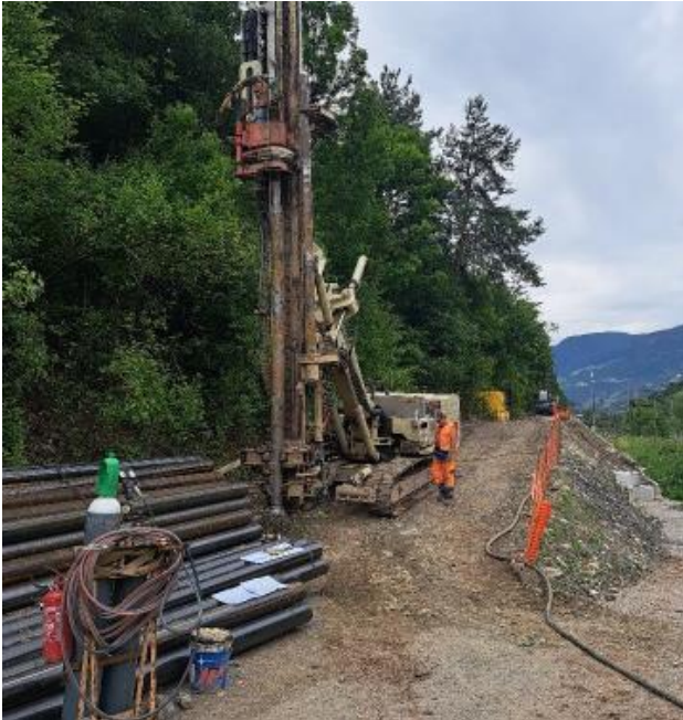
Figura 4 – Infissione di micropali presso il cantiere di Funes
